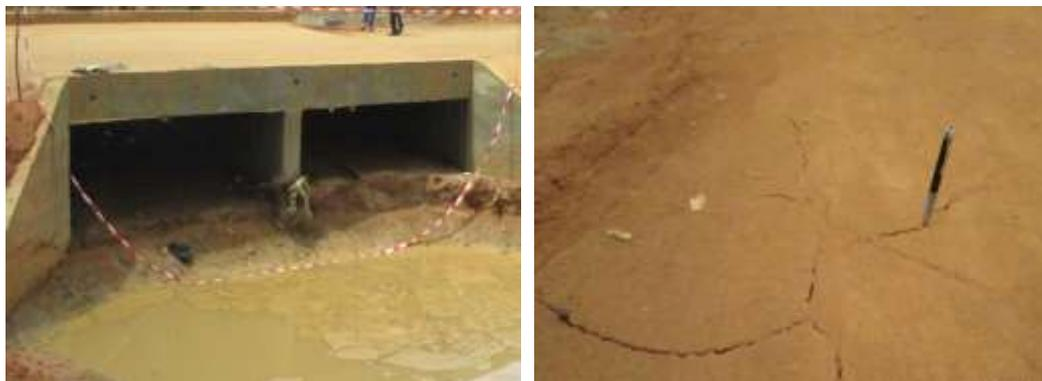
**Photo 9 et 10 : Aperçu du phénomène de fissuration des sols et de produits de lessivage**
